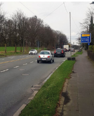
(Abb. 9) Weniger Rückstau auf der B51 – dank einer Initiative der SPD-Fraktion Burscheid. Es wurden hier sinnvolle Rückbaumaßnahmen vorgenommen.
